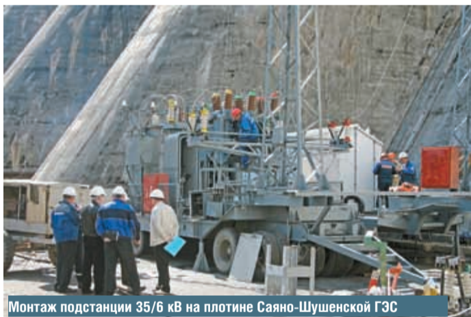
Монтаж подстанции 35/6 кВ на плотине Саяно-Шушенской ГЭС
